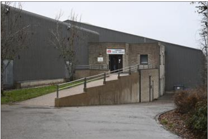
Der Betrieb – wie in der Tennishalle – soll bis zu Fertigstellung der neuen Infrastrukturen aufrechterhalten werden können.
